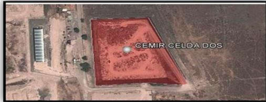
Ilustración 30: Celda 2 de Relleno sanitario
